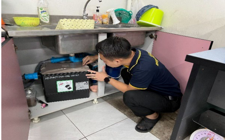
รูปที่ 4 มีการตรวจสอบ ปรับปรุง ซ่อมแซมถังดักไขมัน
